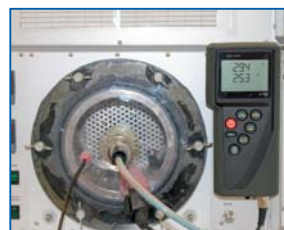
Klimaschrankprüfungen Quality control of climatic cabinets
